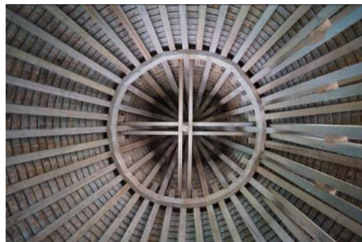
Крыши Сорокской крепости: деревянные конструкции, состоящие из балочных перекрытий и деревянной черепицы
