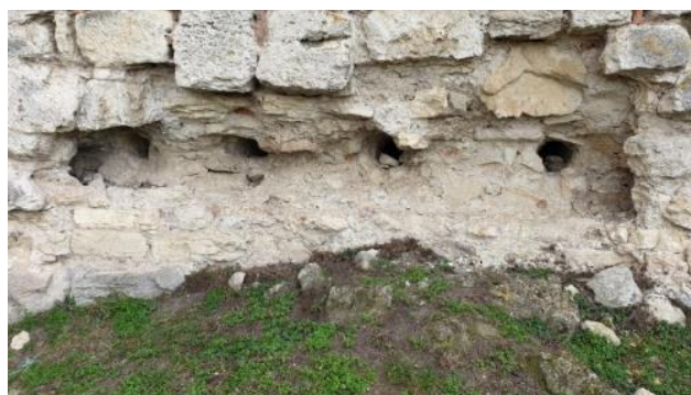
Обрушение и локальная потеря колотого камня в пустотах, образовавшихся после разрушения деревянной дранки
