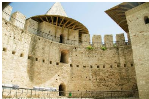
Крыши Сорокской крепости: деревянные конструкции, состоящие из балочных перекрытий и деревянной черепицы
