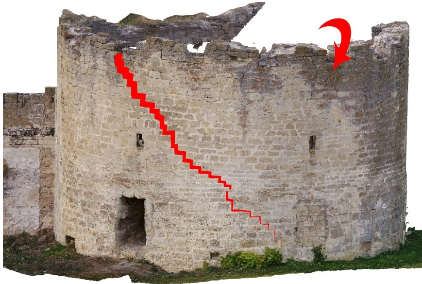
Типичное кинематическое сдвижение участка кладки в случае овальных зданий подобных башне В3
