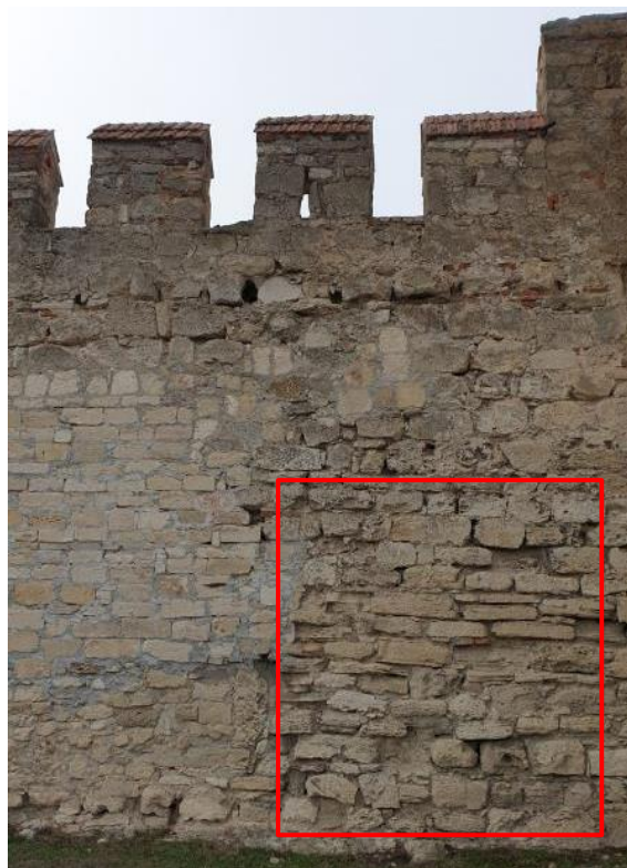
Разрушение швов, деградация каменной облицовки, выпадения камней
