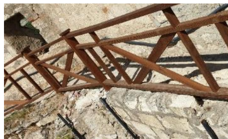
Ребенок может провалиться сквозь сетку перил
